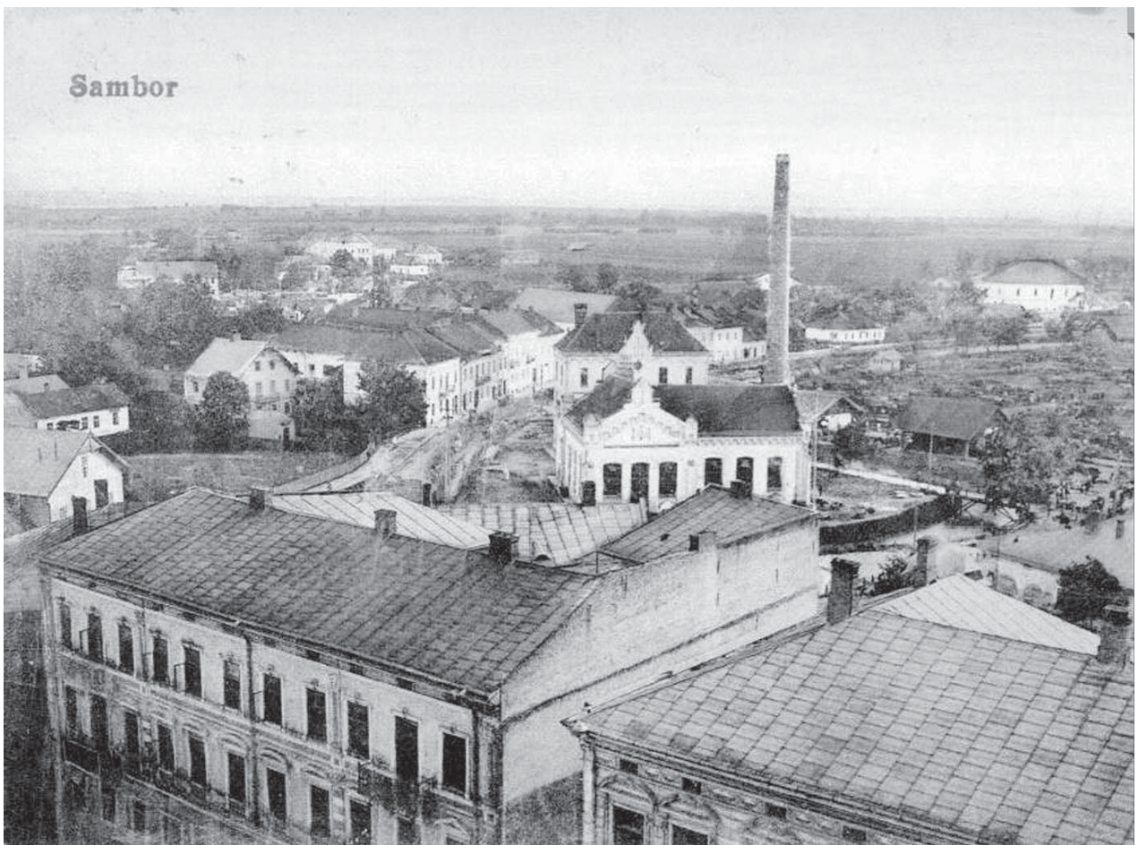
Прокладання каналізаційного каналу у центрі вулиці. Поштівка накладом друкарні Альтера Лібермана (1917 – 1918)
